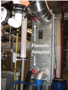
Abbildung 3: Comprex<sup>®</sup>-Reinigung eines Plattenwärmetauschers im eingebauten Zustand
