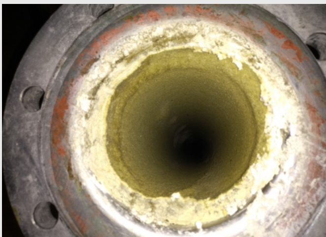
Bild 3: Ablagerungen in Schlammeleitung einer Kläranlage und stationäre Complex-Anlage
